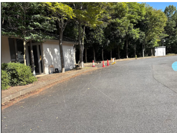
作業完了後（通路脇）
