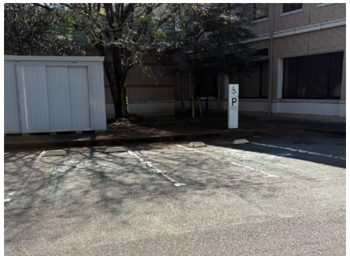
作業完了後（駐車エリア）
