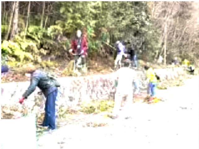
西側道路斜面の枝打ちと草刈り
