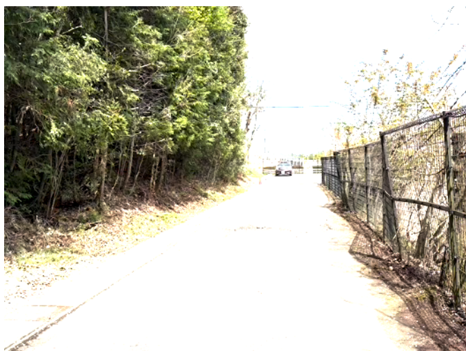
正面西側道路斜面を除草、清掃
