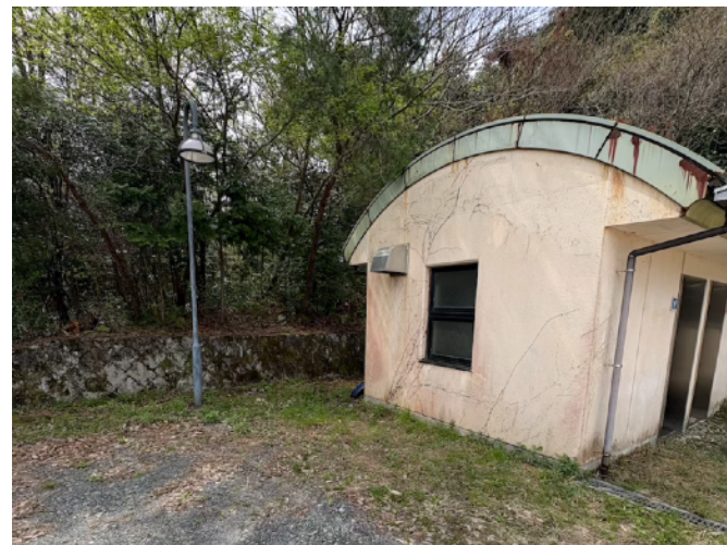
駐車場トイレ脇の枯れ枝・落ち葉を清掃
