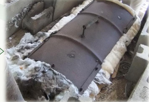
グラスウールで断熱
