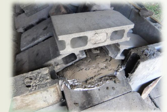
焚口をブロックで作成、 隙間を粘土で目張り
