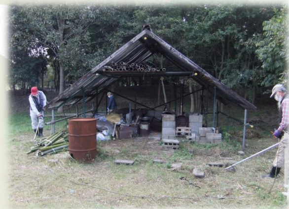
焚口をブロックで作成、 隙間を粘土で目張り
