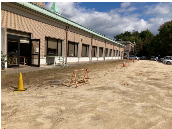
駐車場周辺の除草
