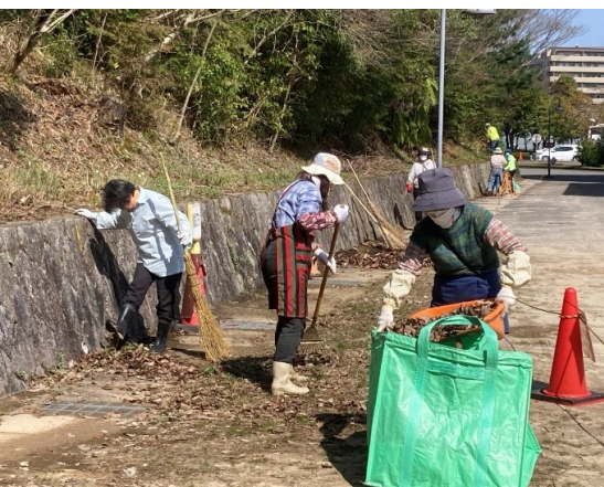
西側石積み下の落葉除去
