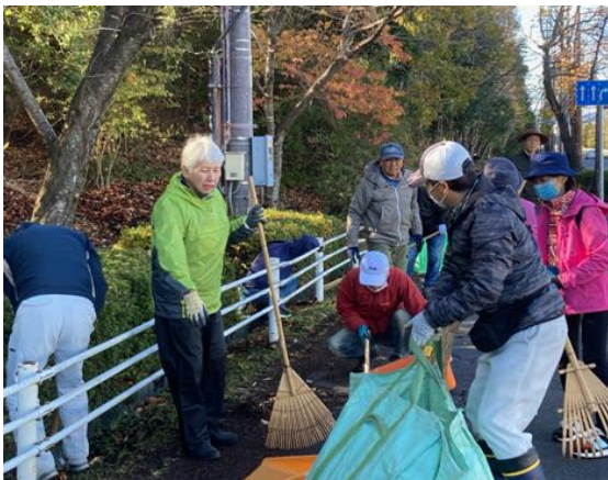
歩道側溝の落葉等の除去
