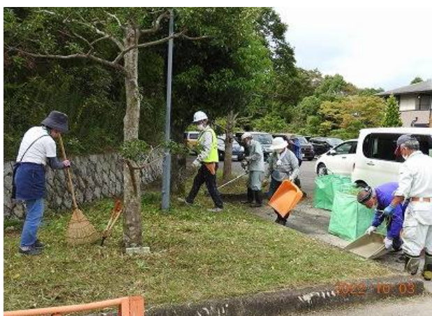
駐車場横の下草刈作業
