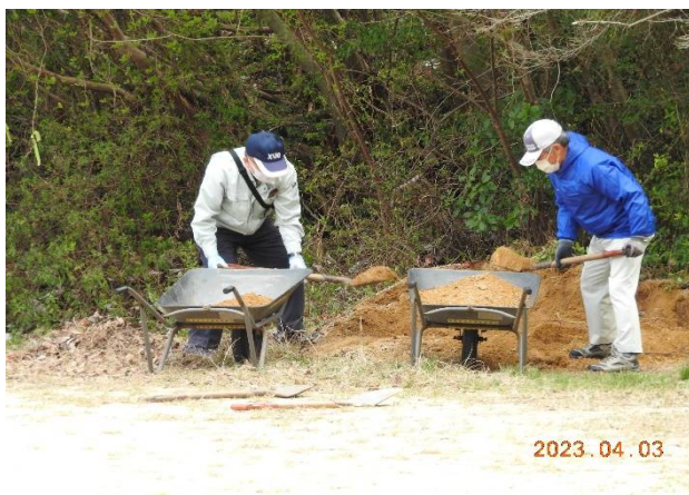
グラウンドの穴埋め作業、砂を積み込み
