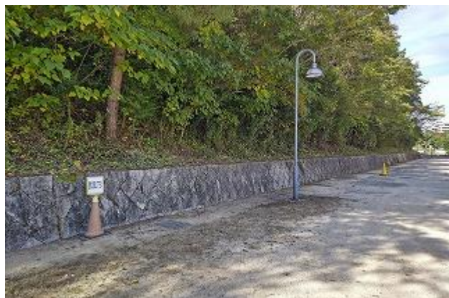
終了後の南側通路部分、見違えるようです
