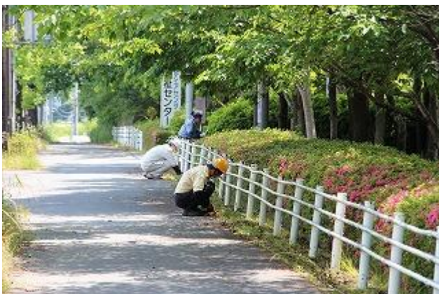
道路沿いの除草作業
